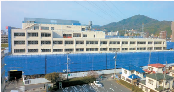
▲ペールをぬぎつつある新病院(北側)
