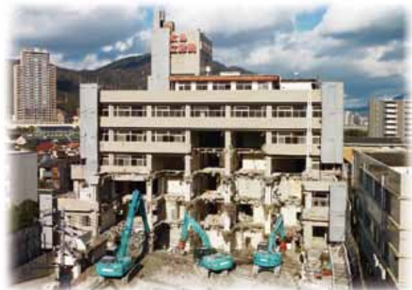
◀旧病院本館解体工事
